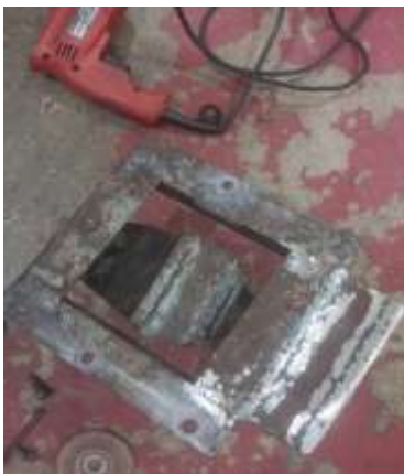
Gambar 7. Proses Pembuatan Dudukan Mesin
